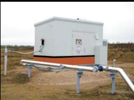
В каждом комплекте компрессора содержится ряд циклических обводных труб для контроля за работой установки. Это необходимо, потому что добываемый из скважины газ варьирует.
